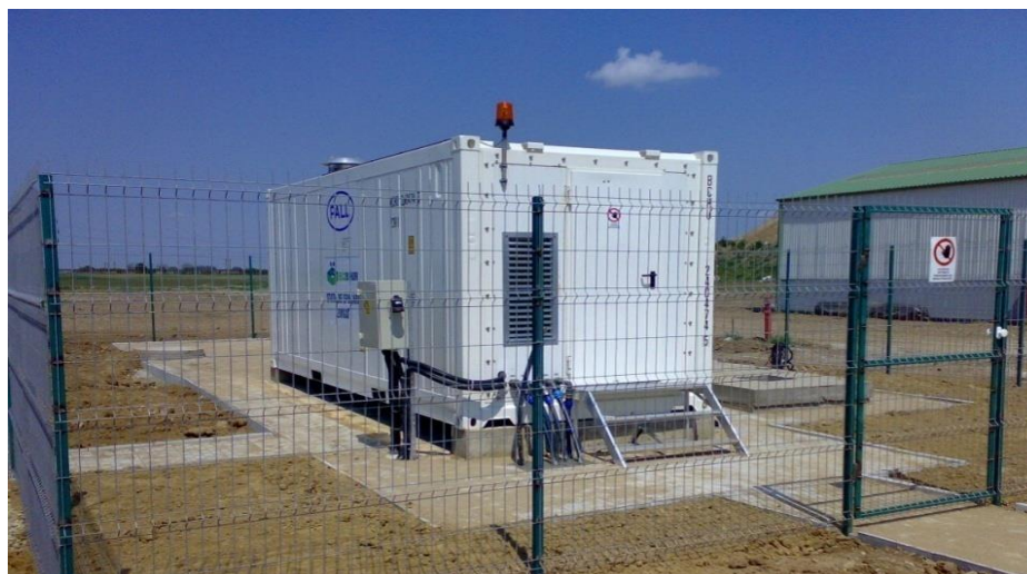
Figura nr.8 Stația de tratare a levigatului Ciocanesti, cu osmoza inversa
